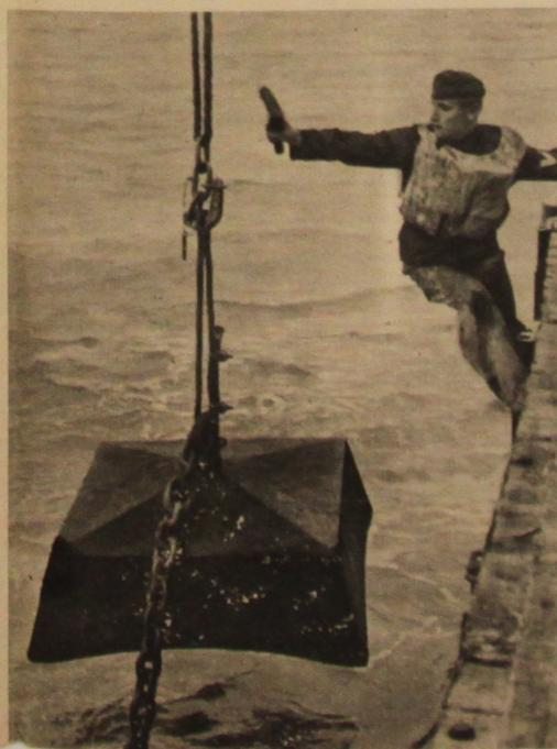
Links Mitte und links Meilenweit sind die eigenen Häfen durch enge Stahlnetze gesichert, die das Eindringen feindlicher Einheiten verhindern. Die Netze sind an Bojen festgemacht und werden durch schwere Gewichte in anstrengender und gefährlicher Arbeit verankert
